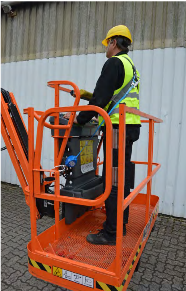
Abb. 3.5.4-02 Einsatz eines Höhensichtungsgeräts im Arbeitskorb
